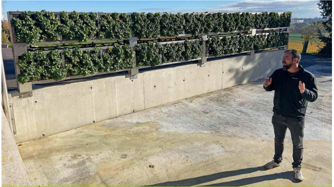
Nicolas Ecabert lors de la séance d'explications. Chacun des modules est rempli d'un substrat composé de fibre de bois, matières organiques, terre végétale et billes d'argile concassées. En raison de la dégradation du substrat, il faut un apport de compost une fois par an par module.
